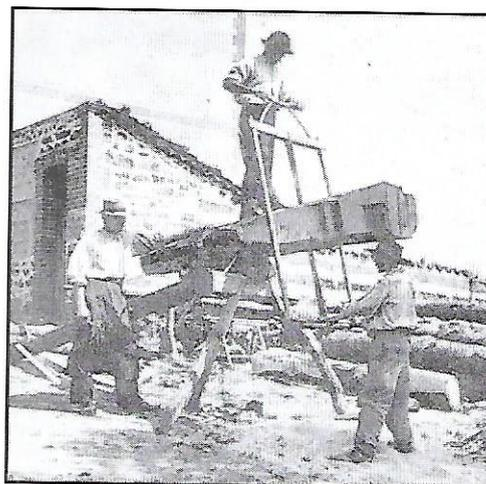
**Les scieurs de long** travaillent par groupe de deux ou trois : le chevrier sur le tronc est chargé de diriger la scie, le renard en dessous du tronc tire la scie et le 3<sup>ème</sup>, le doleur est chargé d'affûter les scies et d'équarrir le tronc avant de le débiter.
